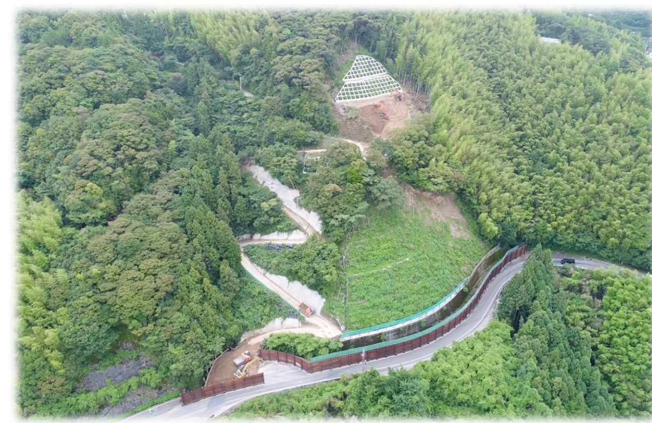
施工状況(切土掘削及び場内運搬)
