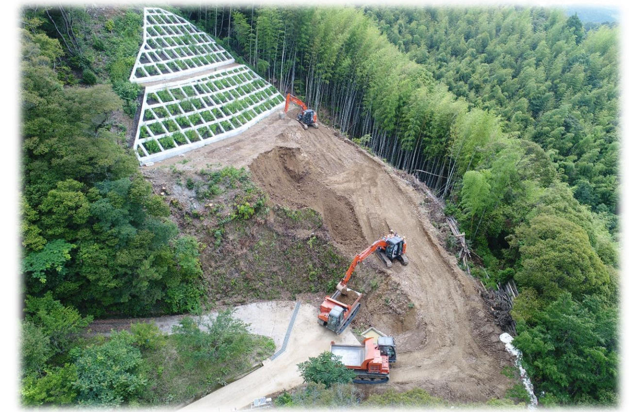
施工状況(切土掘削及び場内運搬)
