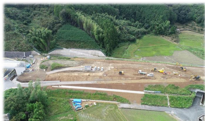
道路の基礎となる盛土をしています。マシンコントロールブルドーザーやRTK-GNSSと言われる技術を用いた振動ローラーを使用し、最先端技術で高品質な施工を実施しています。
