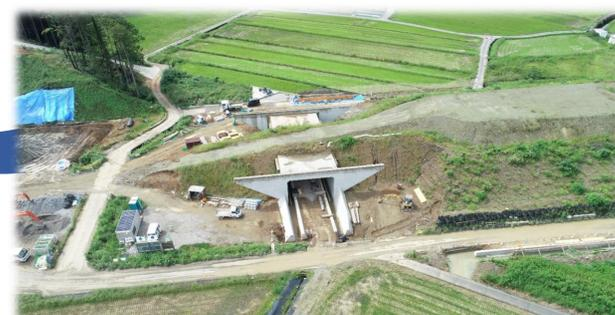
ボックスカルバートの内部や両端部の排水構造物などを施工中です。道路完成後までに排水対策を十分に施すことで、今後の道路メンテナンスや機能の維持、周囲の排水機能の向上にも貢献します。
