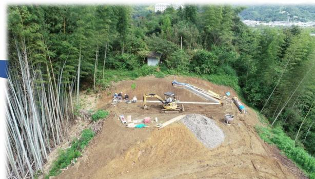
現場の中間付近に存在していた山は、現在掘削途中です。完成予定の道路を挟むようにして、山を切崩し、山肌に入道として使用するスロープを施工しています。
