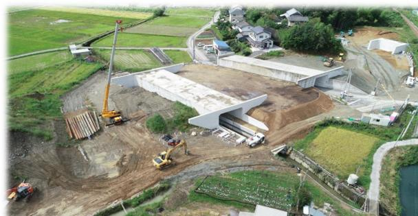
終点付近の波川箇所では、2基のボックスカルバート間の盛土を施工中。ここでも鎌田箇所と同様、最先端のICT技術を駆使して盛土を施工しています。
