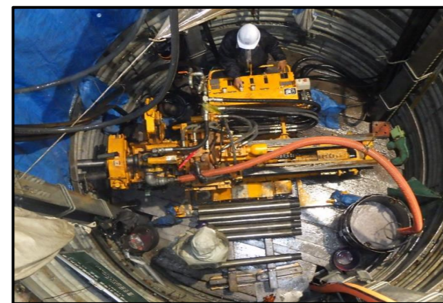
施工状況(集水井内)
