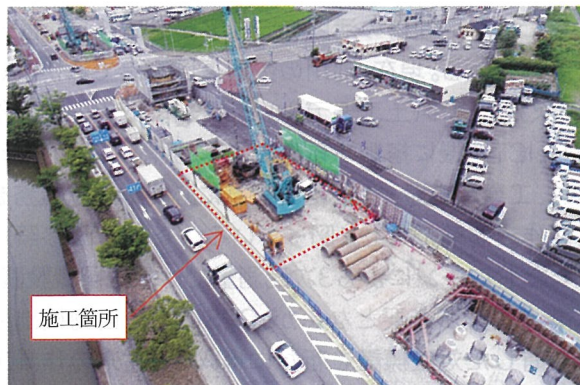
図-4 橋梁下部工事の施工状況
