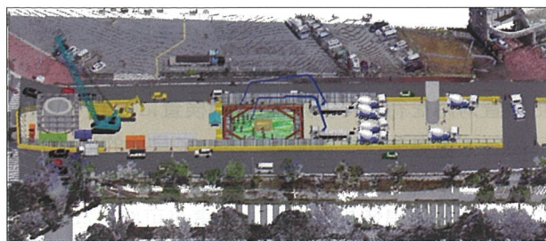
図-7 底版コンクリート打設時におけるミキサー車の運搬計画
