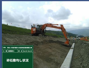
無丁張にて碎石敷均し作業
