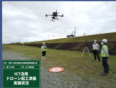
UAV（ドローン）を用いた起工測量（空中写真測量）
