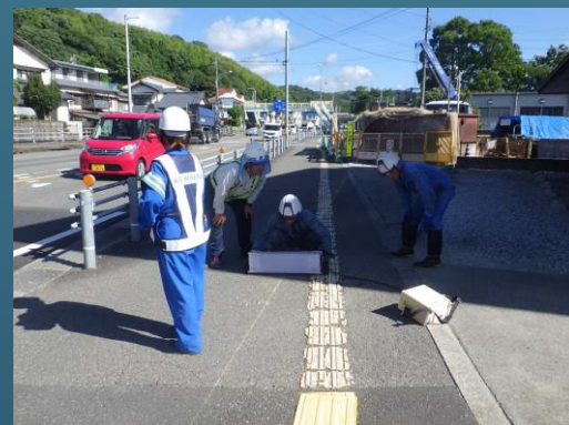
電磁波レーダーによる測定
