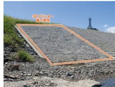
同社が手掛けた工事では、新設護岸と既設護岸との取り合わせ区間にねじれた形状が生じるため、自由形状でブロックをつくれる3Dプリンターを使った。3Dプリンターを使用することで、工期も約4割短縮できる。人手不足が問題となっている土木工事においては大きなメリットだ。さらに、護岸ブロックの表面に凹凸を付けて自然石に近い形状にし、景観に配慮した。
