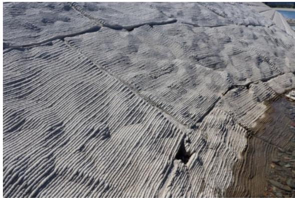
福留開発が3Dプリンターを使用して施工した護岸ブロック（写真：日経クロステック）
