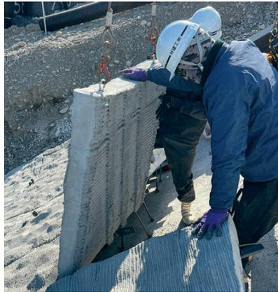
資料3 ■ 印刷した型枠を据え付ける様子
