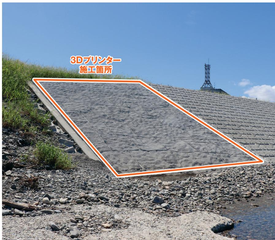
資料1 ■ 3Dプリンターでつくった擬石型枠を使用した施工箇所 (出所:日経クロステック)
