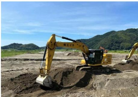
写真-1 GNSS測位方式のICT建機（左）
