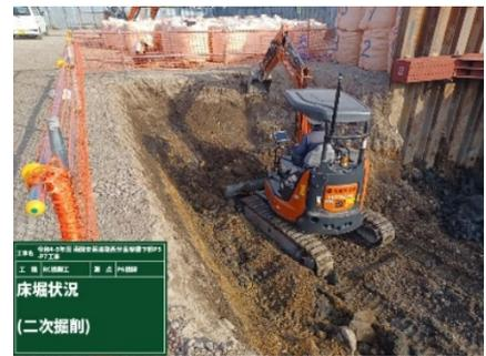
写真-2 TS測位方式のICT建機
