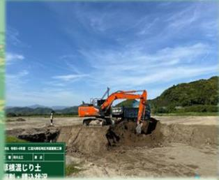
3次元設計データ※を基にバックホウで掘削を行います。
