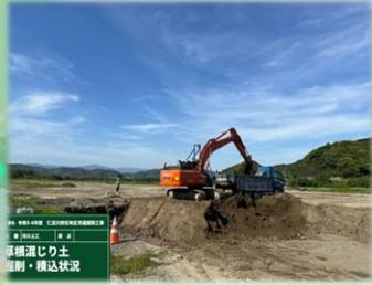
掘削によって発生した土砂を10tダンプトラックに積み込みます。
