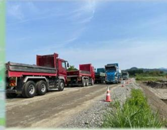
10tダンプトラックで残土場まで運搬します。
